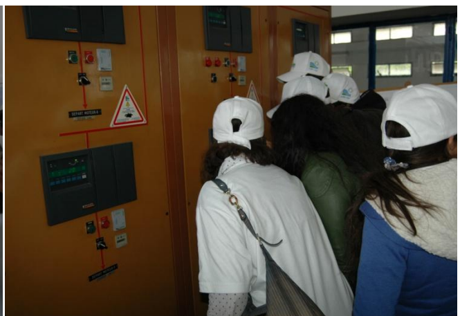
Site 1 Réservoir d'alimentation en eau potable
